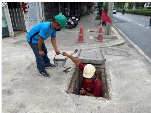
ภาพที่ 55 (ต่อ) กิจกรรมขุดลอกตะกอนที่ระบายน้ำ
